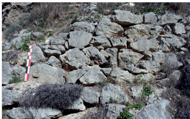
Fig. 13 : Mur MR5 composé de moellons calcaires extraits *in situ*. © F. Loppe, 2018.
